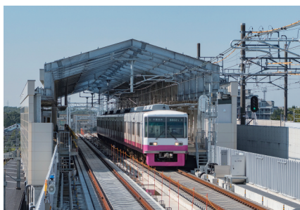
京成建設が施工した新京成線の連続立体交差事業
