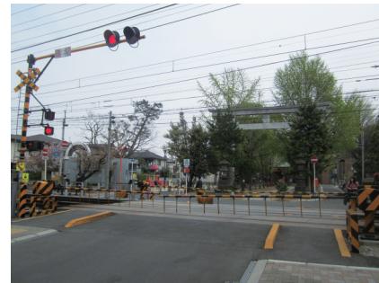
オーバーハング型踏切警報機
