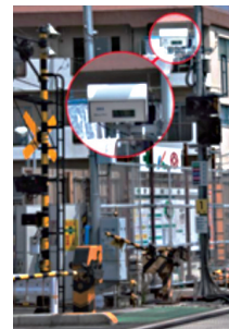
3次元レーザーダー式 自動障害物検知装置
