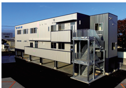
京成建設が施工した関東鉄道守谷営業所
