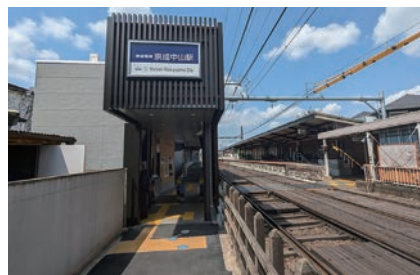
京成中山駅駅舎耐震化
