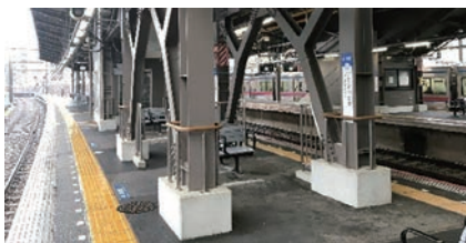
市川真間駅耐震補強工事
