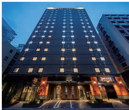
（仮称）アパホテル〈大森駅前東〉新築工事
