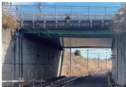
宮崎第1跨線橋補修工事（2024年度）
