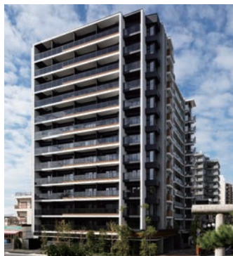
クリオラベルヴィ船橋新築工事
