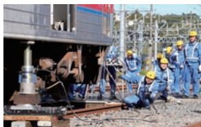
異常時総合訓練（脱線復旧）
