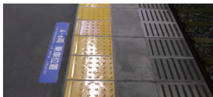
内方線付点状ブロック
