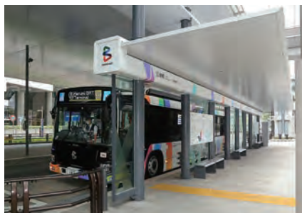
東京BRT停留施設（新橋駅）
