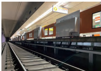
成田空港駅ホームドア整備工事
