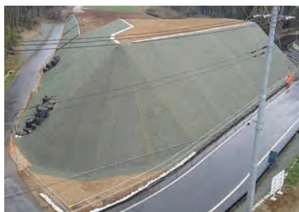
圏央道多古地区改良工事
