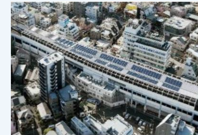
太陽光パネルの設置
