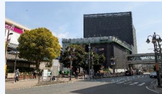
津田沼12番街ビル（改修工事中）
