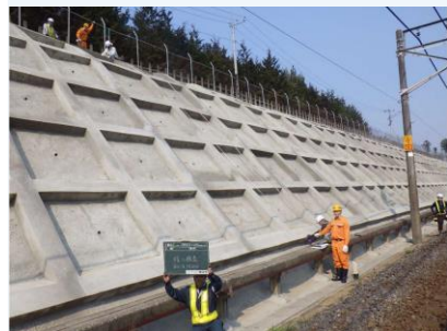
法面補強工事
