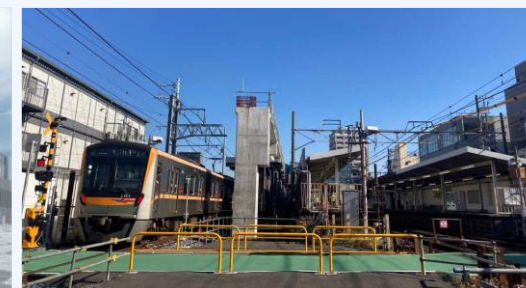
仮下り線ホーム
