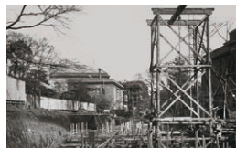
上野公園内での工事 (1932年)
