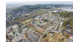
宗吾車両基地拡充工事
