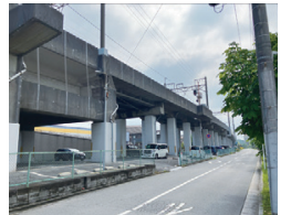
工事が完了した千葉寺駅～ちはら駅間の一部
