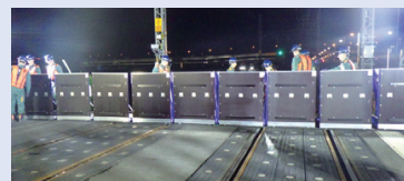
止水板の設置完了の様子
