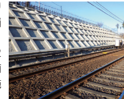
工事が完了した京成成田駅～空港第2ビル駅間の一部区間
