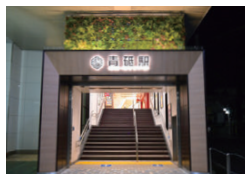
壁面緑化を実施した駅出入口
