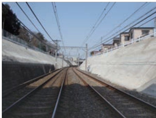
京成千葉線における法面防護工事
