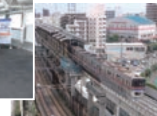
高架化された曳舟駅上り線ホーム
