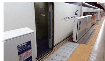
成田空港駅くし状ゴム
