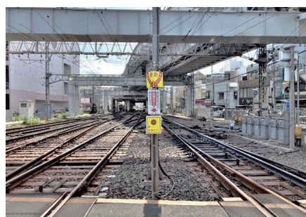
踏切内の非常ボタン
