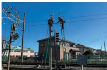
架線断線復旧訓練
