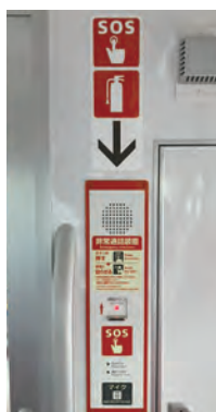
非常通話(通報)装置
