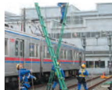
電車線復旧訓練
