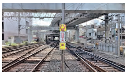
踏切内の非常ボタン
