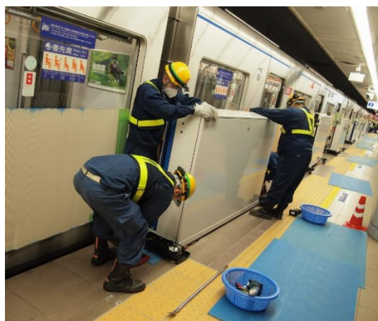
〈ホームドア設置の様子〉
