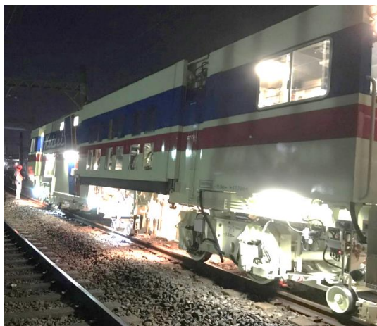
〈線路保守作業の様子〉
