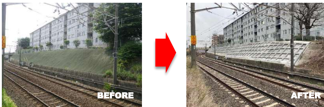
▲法面補強工事イメージ(谷津駅～京成津田沼駅間 2023 年度実施)
