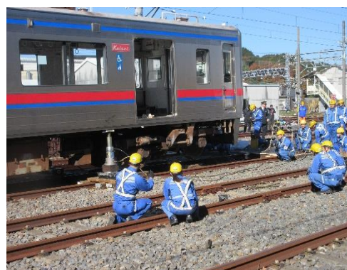
脱線復旧作業
