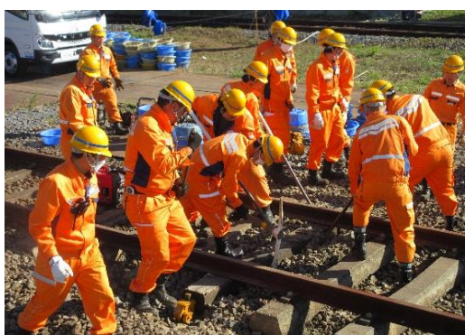
軌道復旧作業
