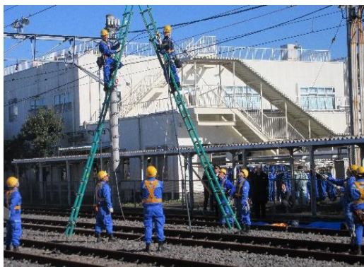
電車線復旧作業
