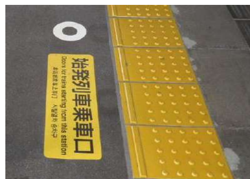
内方線付き点状ブロック
