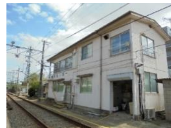
津田沼車庫旧事務所
