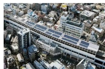
太陽光パネル
