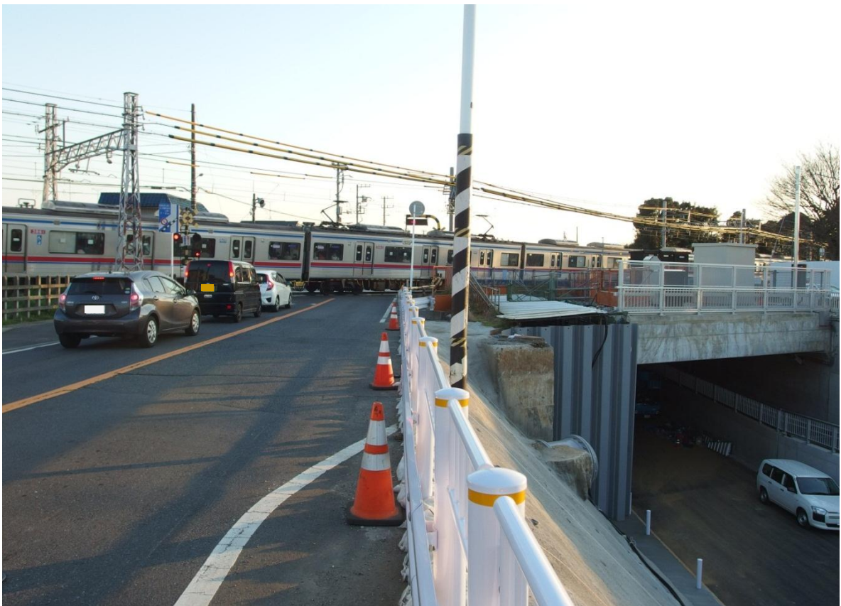
道路切替工事が進む実籾第4号踏切道
