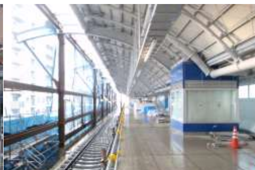
工事が進む京成曳舟駅新ホーム
