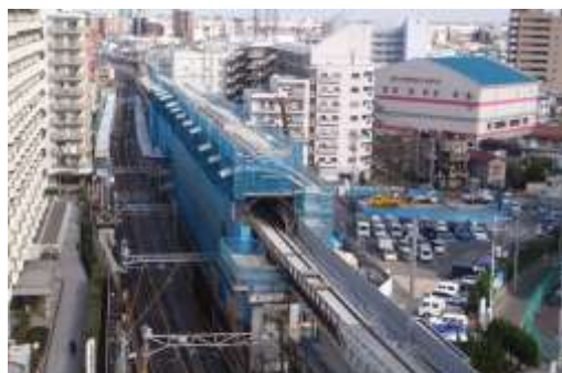
上り線が高架になる京成曳舟駅
