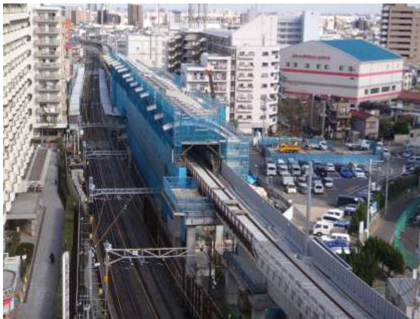
上り線が高架になる京成曳舟駅
