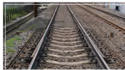
ロングレール伸縮継ぎ目
