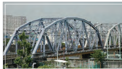
低VOC塗装の隅田川橋梁
