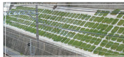
東中山駅の法面緑化
