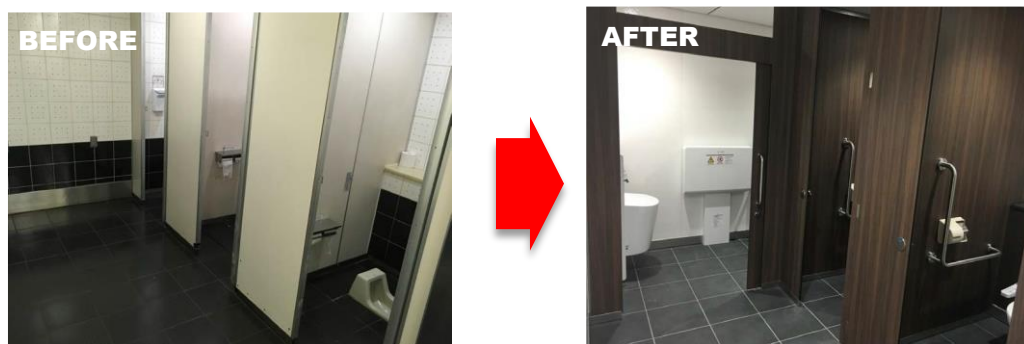
▲成田空港駅トイレのリニューアル
