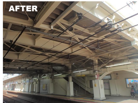
▲お花茶屋駅 耐震補強工事の様子
