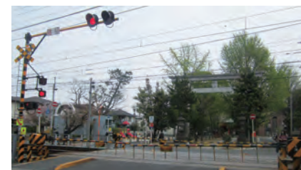
オーバークング型踏切警報機
