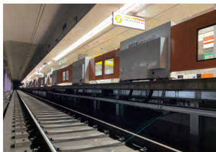
成田空港駅ホームドア整備工事
