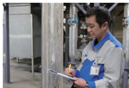
京成ビルサービス作業員
