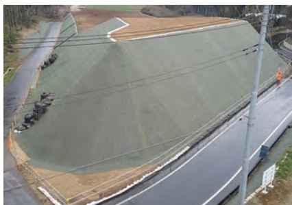
圏央道多古地区改良工事
