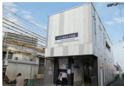
京成大久保駅の耐震補強
