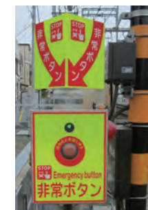
押ボタン式踏切支障報知装置
