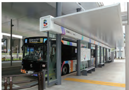
東京BRT停留施設 (新橋駅)
