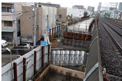
押上線連続立体交差事業（四ツ木駅～青砥駅間）
