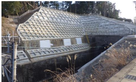
法面補強工事 （宗吾参道駅～公津の杜駅間）
