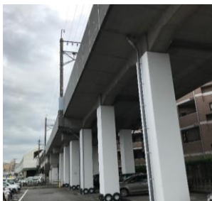
高架橋柱耐震補強工事 （千葉中央駅～千葉寺駅間）
