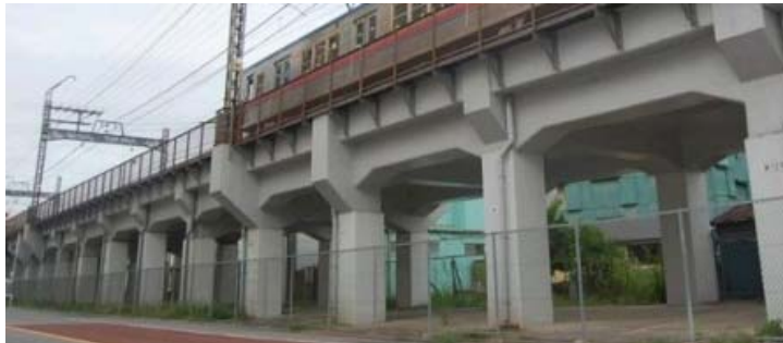
高架橋耐震補強
