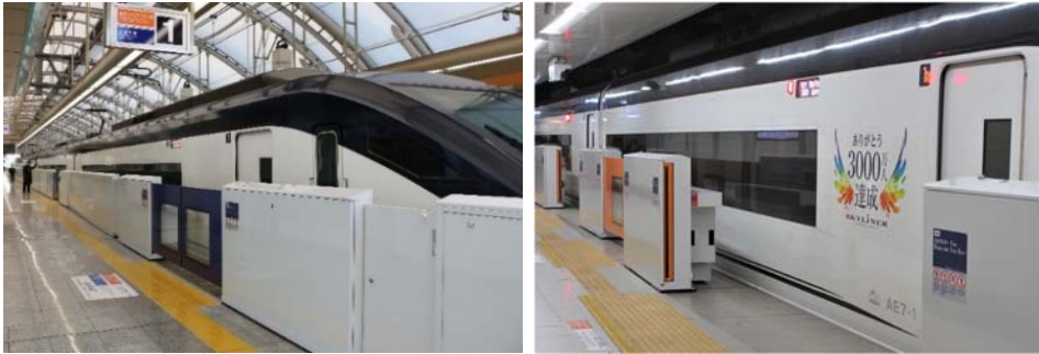
ホームドア（写真は日暮里駅・空港第2ビル駅）
