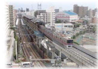
高架化された曳舟駅上り線
