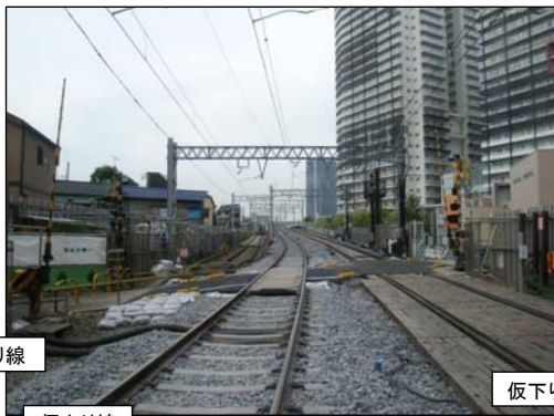
墨田区内連続立体化工事 2次仮上り線 (押上2号踏切付近)
