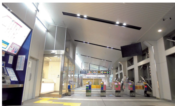
駅舎改良工事が完了した京成津田沼駅
