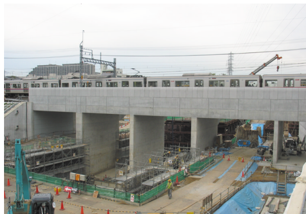
千葉線における道路との立体交差化工事
