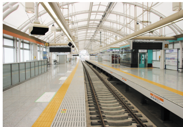
日暮里駅3階の下り線ホーム
