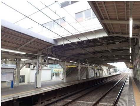
船橋競馬場駅駅舎耐震補強の施工状況
