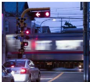
オーバーハング型踏切警報機
