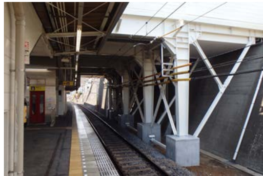
谷津駅駅舎耐震補強の施工状況
