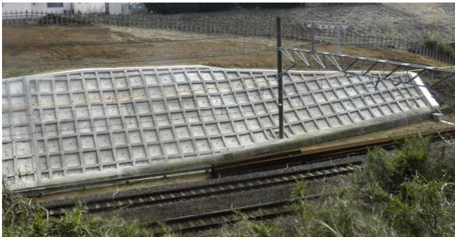
公津の杜～京成成田間の法面補強
