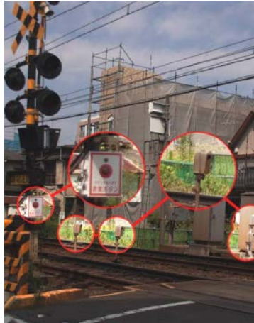
踏切支障報知装置 と自動障害物検知装置
